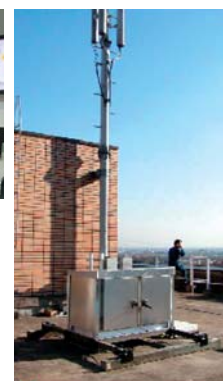
省エネ・軽量型キュービクル、FRP製アンテナ支持柱
