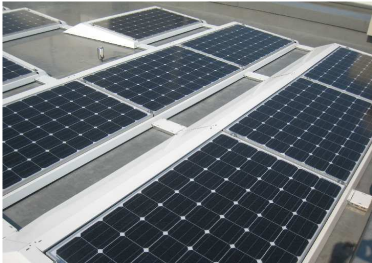
屋上にパネル設置（単結晶250W×12枚）
