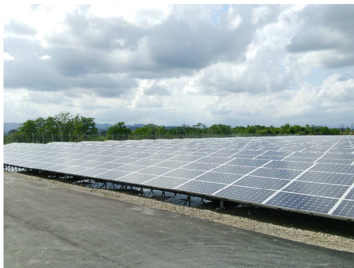
当社が栃木県壬生町に設置した太陽光発電システム
