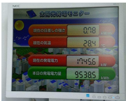
日々の発電状況を“見える化”してリアルタイムに監視
