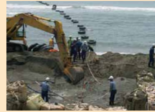
海底ケーブル陸揚げ工事 2008年7月御前崎 (提供:気象庁様)
