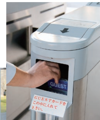
全天候型フラッパーゲートと ゲストカード回収Box(写真2) 入退場が多い門にはフラッパーゲートが設置された。この門では有人監視の体制がとられ、来訪者の受付も行っている。
