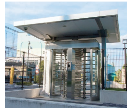
ロータゲート(写真1) 無人となる門には共連れ防止を含めたセキュリティ強化のために、ロータゲートが導入された。各ゲートにはIPインターフォンとカードリーダー、監視カメラが設置されている。
