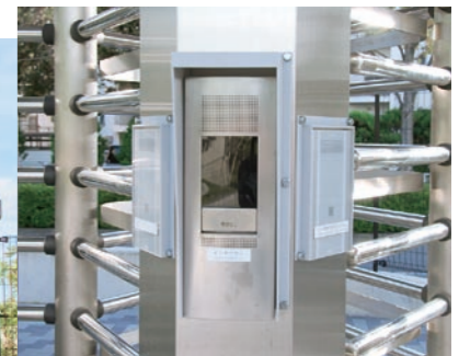
ロータゲート(写真1) 無人となる門には共連れ防止を含めたセキュリティ強化のために、ロータゲートが導入された。各ゲートにはIPインターフォンとカードリーダー、監視カメラが設置されている。
