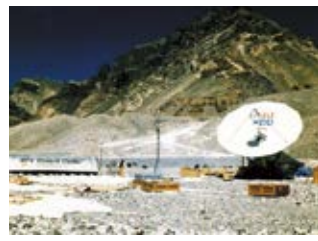
チョモランマ通信設備建設
