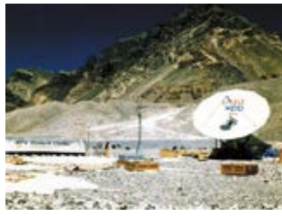
チョモランマ通信設備建設
