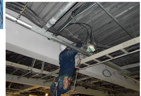
移動体基地局工事:屋内
