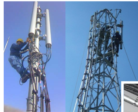
移動体基地局工事:屋外
