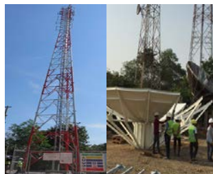
基地局 衛星局構築
