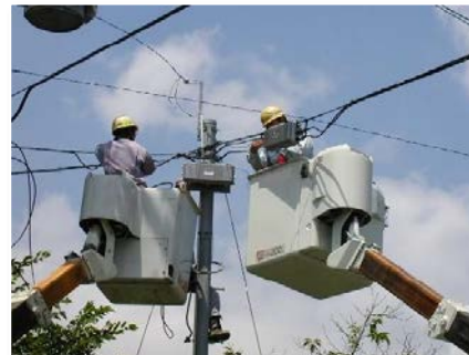
CATV敷設工事
