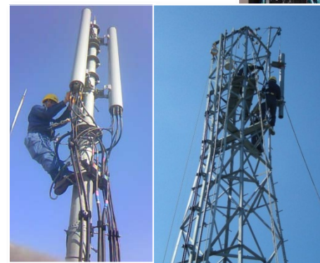
移動体基地局工事
