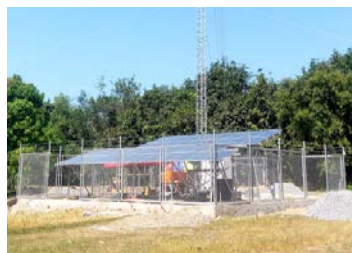
基地局電力供給用 ソーラーパネル構築
