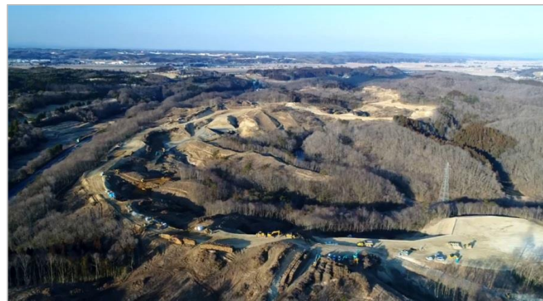
プロジェクト現場全景(大和富谷)
