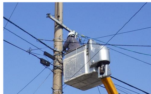
CATV敷設工事
