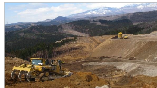
山間地での造成工事(白石)
