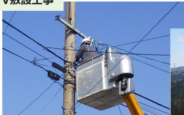
CATV敷設工事
