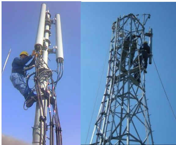
移動体基地局工事
