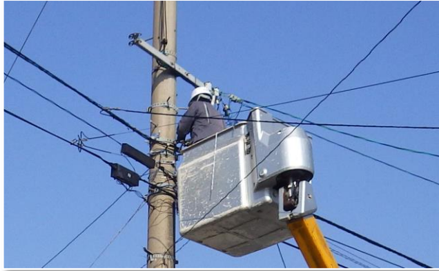
CATV敷設工事
