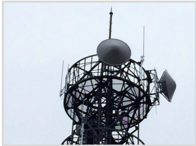
防災行政無線システム
