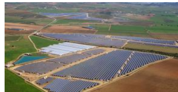
X-Elio社の太陽光発電所 (フエンテ・アラモ、スペイン)
