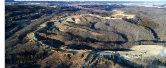
プロジェクト現場全景(大和富谷)
