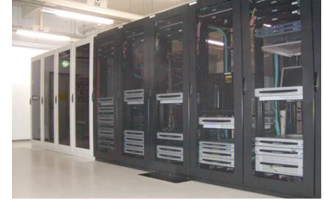
nTOC (NW監視センター)
