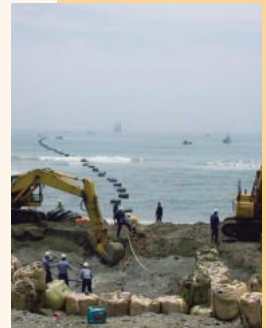
海底ケーブル陸揚げ工事 平成20年御前崎（気象庁様）
