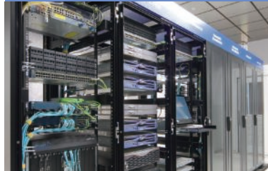
通信事業者向け基幹ネットワーク
