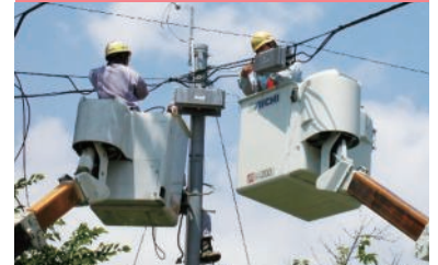
CATV敷設工事
