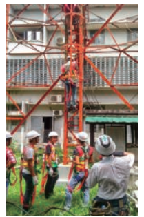
現場作業の様子
