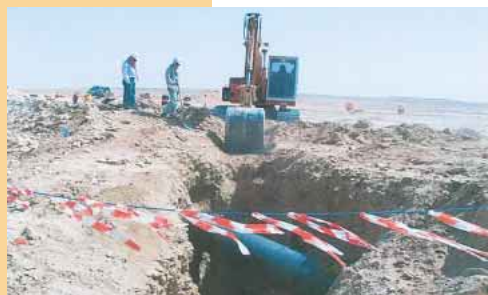
光ケーブル敷設現場
